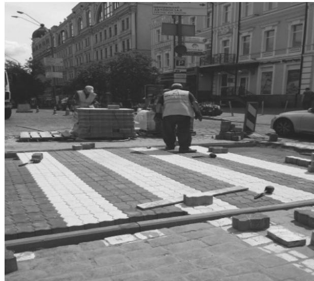
Рис. 1. Влаштування дорожньої розмітки за допомогою ФЕМ на вул. Богдана Хмельницького, 2016 рік
