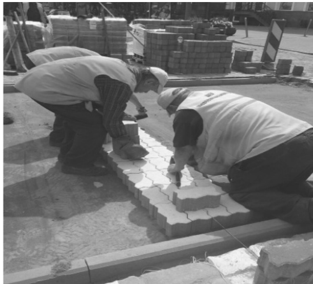
Рис. 1. Влаштування дорожньої розмітки за допомогою ФЕМ на вул. Богдана Хмельницького, 2016 рік
